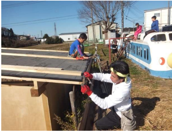
収納小屋の屋根を手直し はしごを押さえてお手伝い
